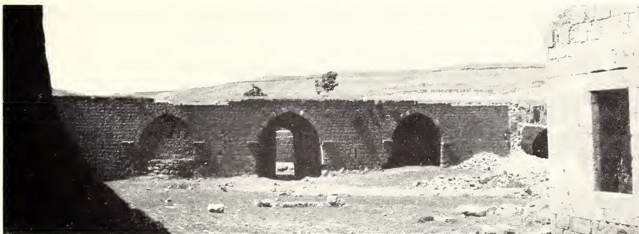
FIG. 18—KHAN D'ER-RESTEN, L'ENTRÉE VUE DE LA COUR
